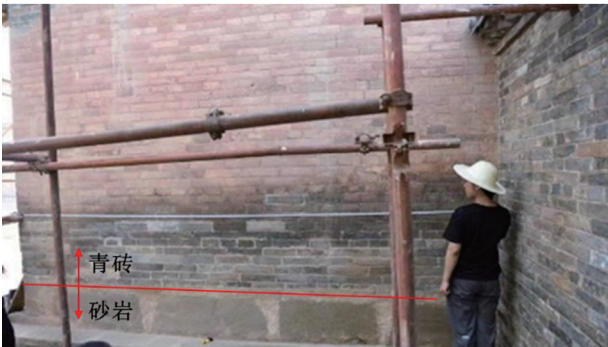
(b) 东墙体外壁面
